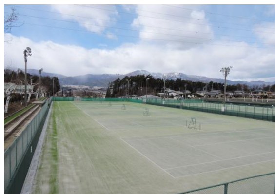
センターテニスコート人工芝敷設
