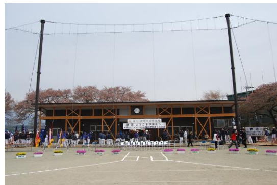
市宮野球場改修工事竣工
