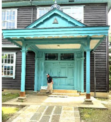
資料館の玄関は、敷石も含め、旧校舎を正確に移築した物です
