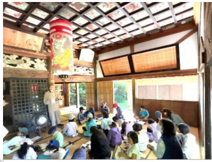
外陣(手前)にある「絵天井」
