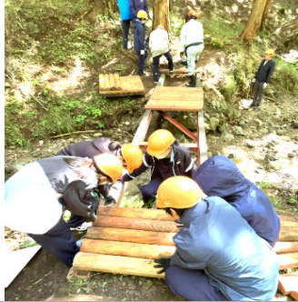
半分に切った丸太を固定して、学有林に入るための新しい橋を作っています。
