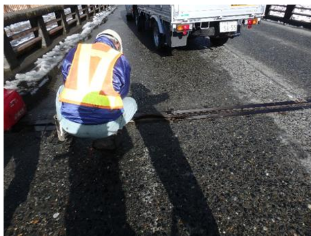
(伸縮装置修繕状況)
