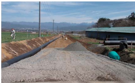
スマートインターチェンジ工事状況
