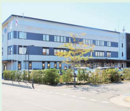
3階建て地場産木造庁舎
