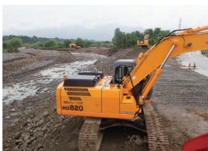
水位低減後の三峰川での復旧工事
