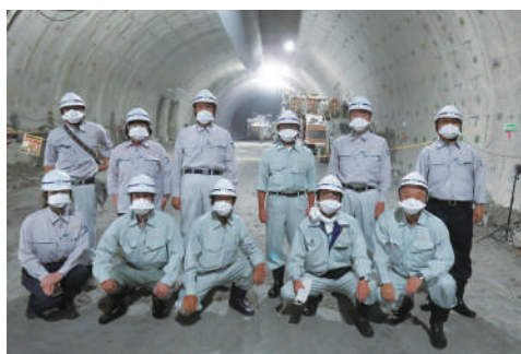
工事中の青崩トンネル(仮称)
