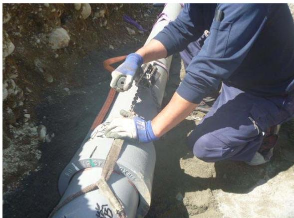
耐震管(ダクタイル鋳鉄管 DIP-GX 継手型)
