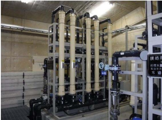
高遠第2簡易水道 半対浄水場(膜ろ過設備)
