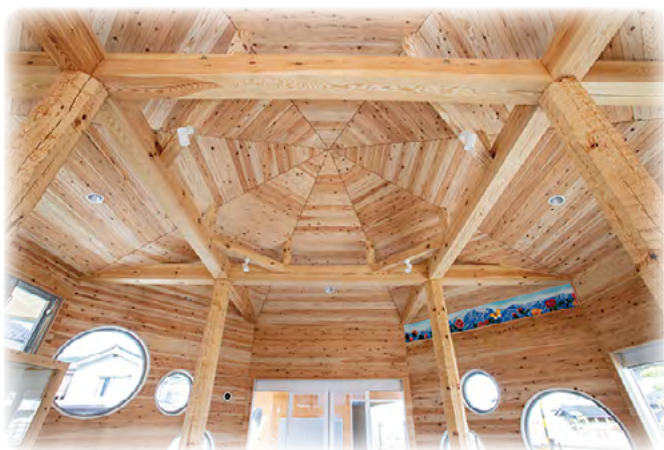
地域産材の活用（沢渡駅駅舎）
