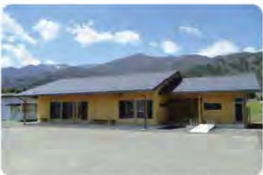
小出一区公民館(平成23年11月完成)
