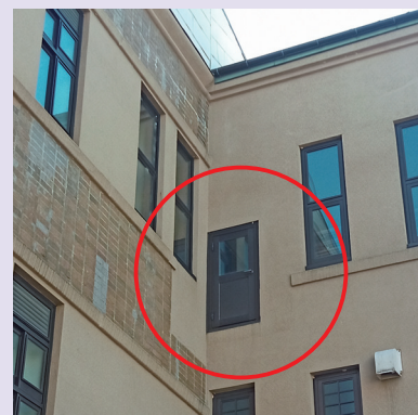
3階倉庫北東側にある扉。開けたらそのまま落ちてしまいそうです。
