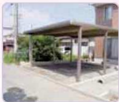
ガレージなどの施工
