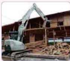
建物の解体工事
