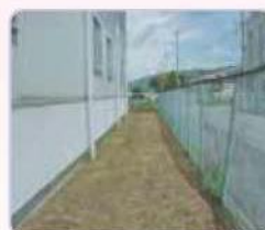
建物周りの除草作業
