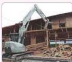
建物の解体工事
