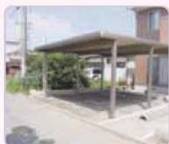
ガレージなどの施工
