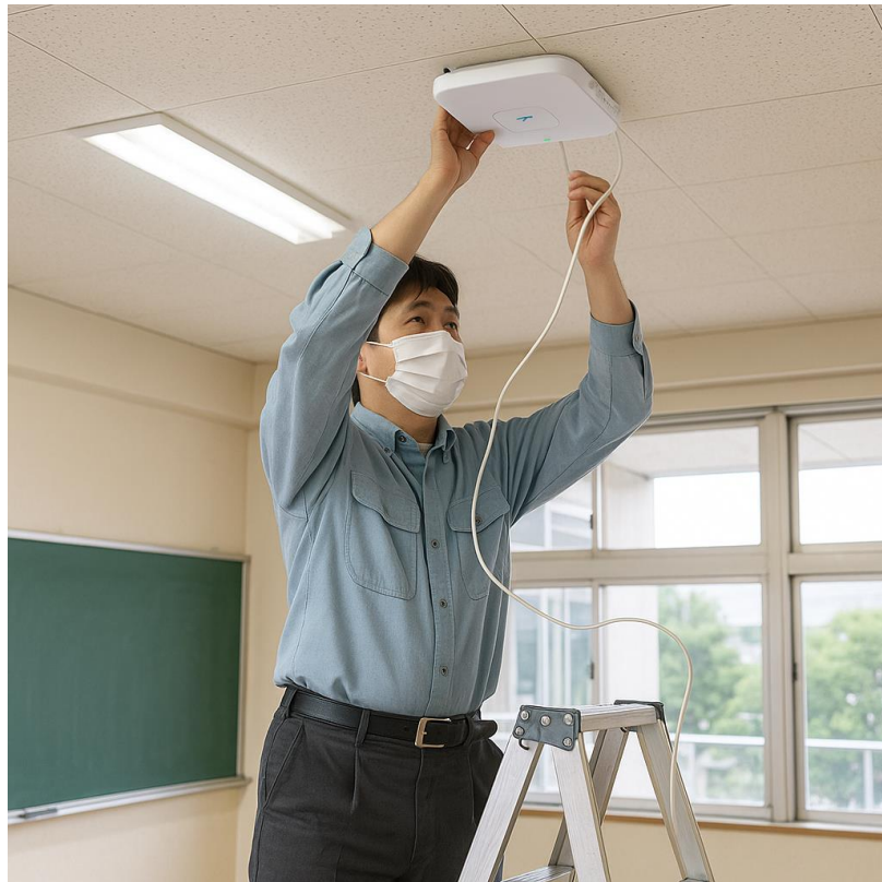
全21校を対象とした設備改修
