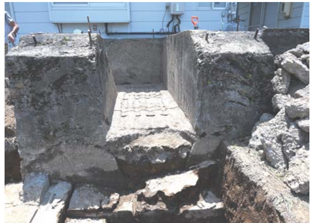
発掘調査で確認された飛行機格納庫 戸袋の状況
