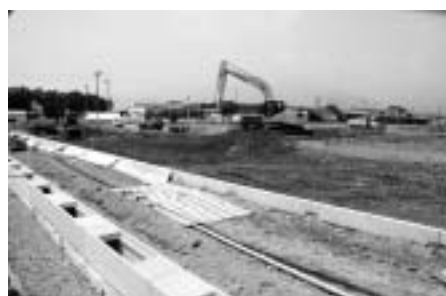
上の原工業団地造成工事
