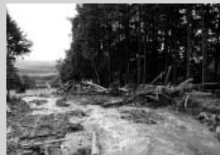
大量の流木と土砂が堆積した前沢川
