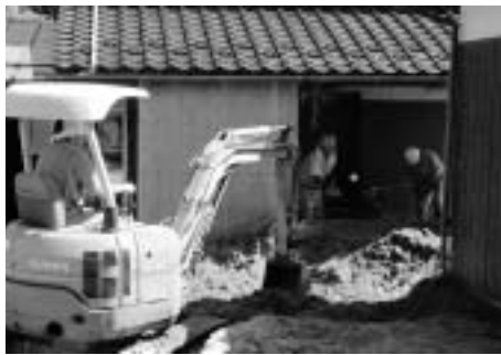
民家に流入した土砂の撤去作業
