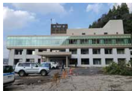
被災した穴水町役場
