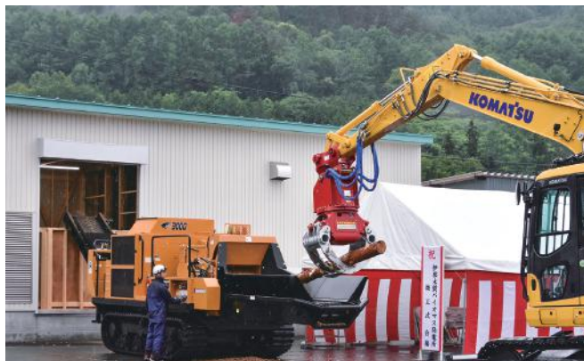
木質バイオマス発電所竣工式
