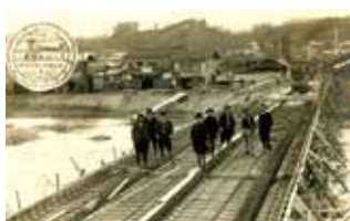
二條(にじょう)橋仮設工事 昭和8年 馬場毅氏提供
