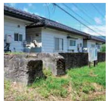
現存する格納庫のコンクリート基礎
