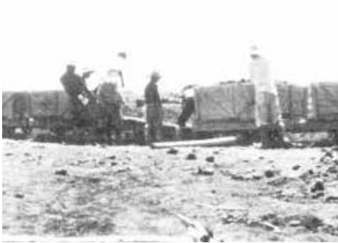
飛行場建設作業の様子
