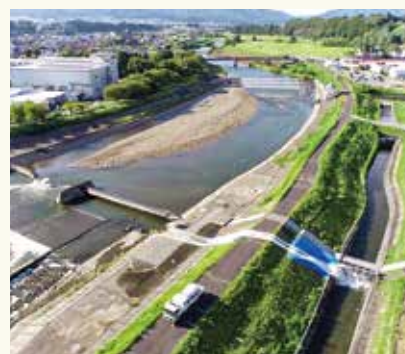
ポンプ車による緊急取水の様子
