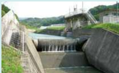
新山川の頭首工
