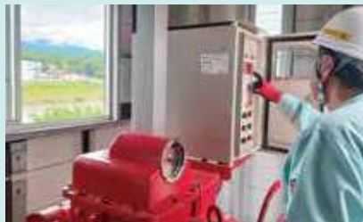
ひ管（堤防を横断する水路）操作の様子
