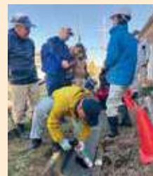
古くなった水路の目地補修
