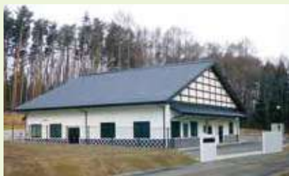
手良浄化センター
