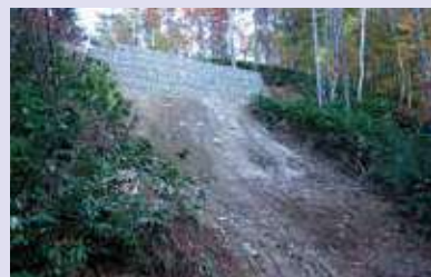
大型ぶとんかごを設置し復旧 (令和4年度災害復旧事業)
