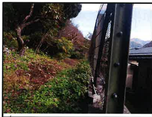
擁壁工及び落石防護工 背面状況
