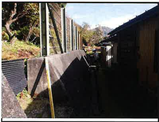
擁壁工及び落石防護工
