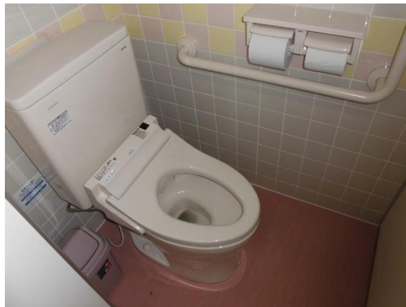
高遠中学校トイレ (洋式化改修)
