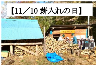
【11/10 薪入れの日】 「上牧里山づくり」の上牧里山自然パークにある、宮の上炭焼き小屋
