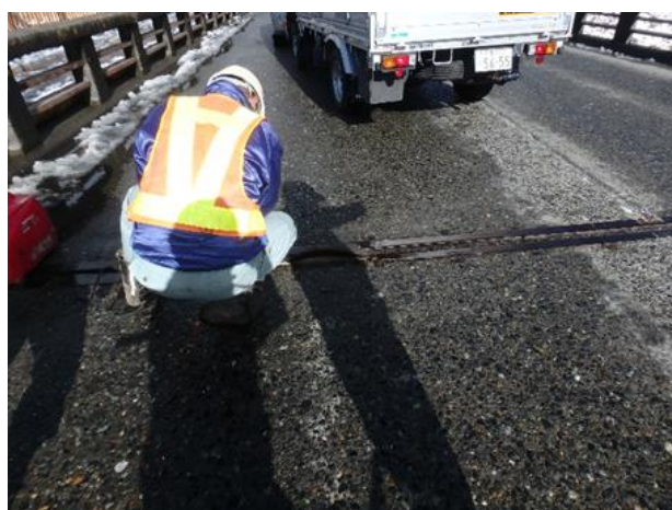
(伸縮装置修繕状況)
