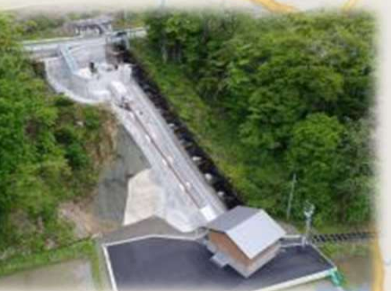
春富土地改良区小水力発電所
