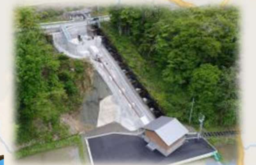
春富土地改良区 小水力発電所
