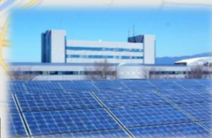
伊那浄水管理センター
