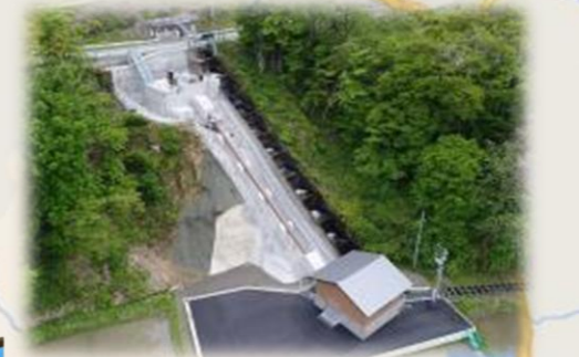
春富土地改良区 小水力発電所
