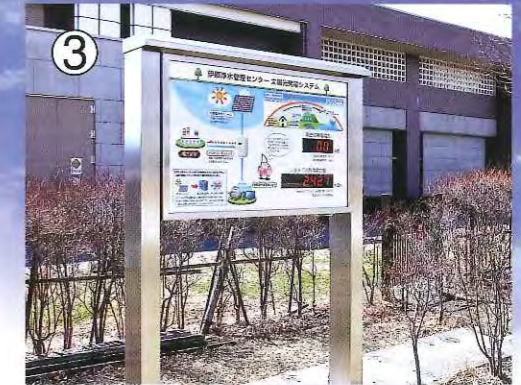
屋外モニター 発電量をリアルタイムで表示します。
