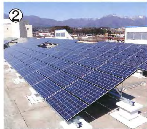
太陽電池モジュール 最大出力100KW (190W×528枚)
