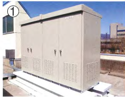
パワーコンディショナ 発電した直流電力を交流電力に変換します。
