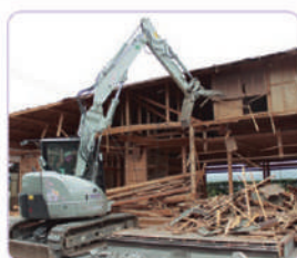
建物の解体工事
