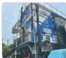
足場の施工・外装リフォーム
