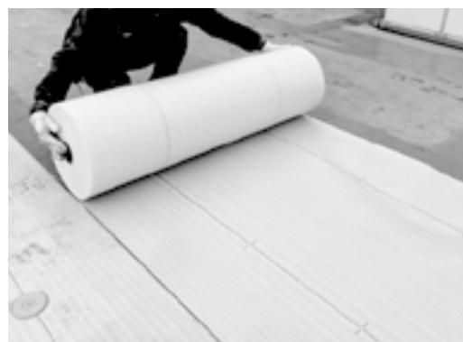
▲ソフマット(屋上防水)
