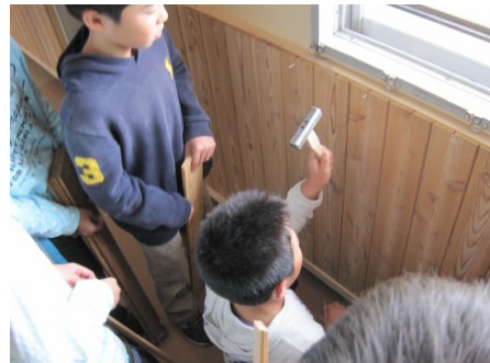
小学校での腰壁板設置作業
