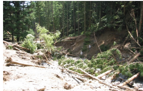
前沢川の土石流下区間
