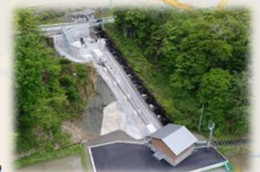
春富土地改良区 小水力発電所
