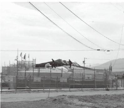
建設が進む西箕輪地域交流センター(仮称)
