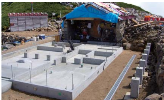
西駒山荘の基礎工事
