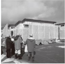
伊那北保育園の建設現場
