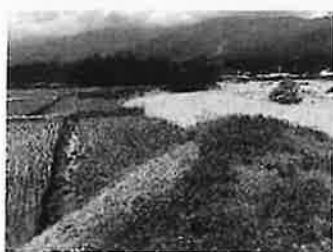
↑東春近三峰川による 水田の洗堀崩落
