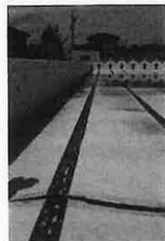
↑壊れた東部中プール
