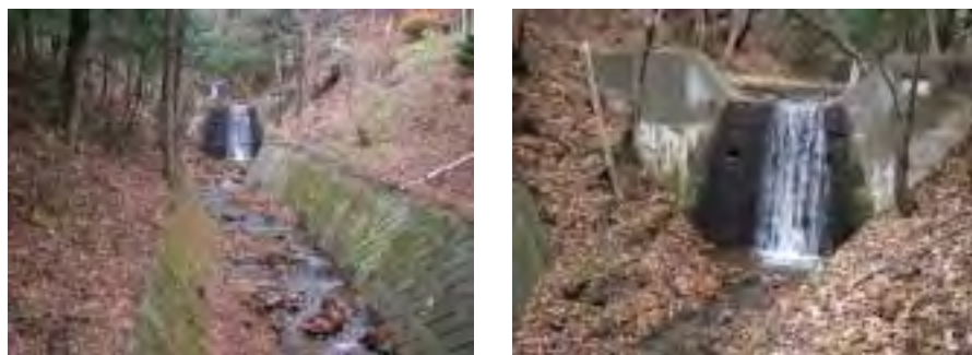
図 6.11 小水力発電の設置位置の現況(西箕輪地区)
