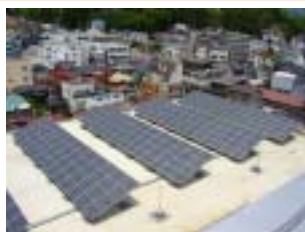
太陽光発電システム (いなっせ立体駐車場屋上)
