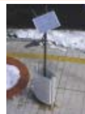
太陽光街路灯 (いなっせ北側駐車場)
