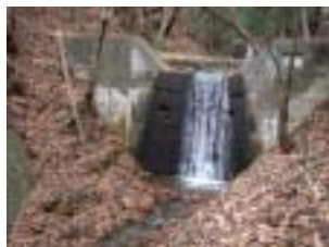
小水力発電 (西箕輪地区)
