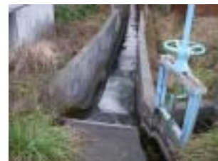
小水力発電 (富県地区)
