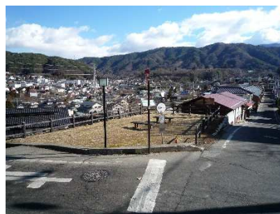
高遠城下の南側の入口、相生町にあります。枡形とは、外敵が一気に侵入することを防ぐために設けられた施設で、江戸時代の文久3年(1863 年)に、城下町が拡張された際に設けられました。当時は道路を挟んで南北約 20m、東西約 13.6mの空間でしたが、現在は北側の一部と石垣が潰れています。
