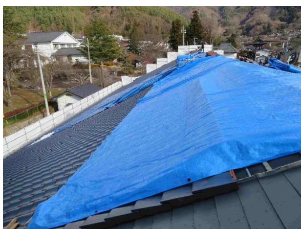
【資料写真 4】 屋根施工状況
