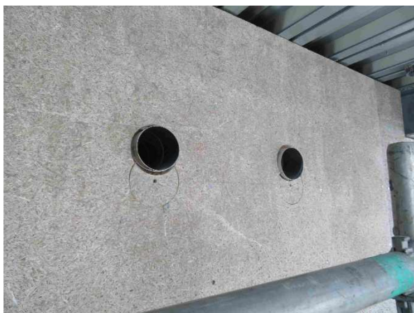
【資料写真 3】 外壁開口部施工状況
