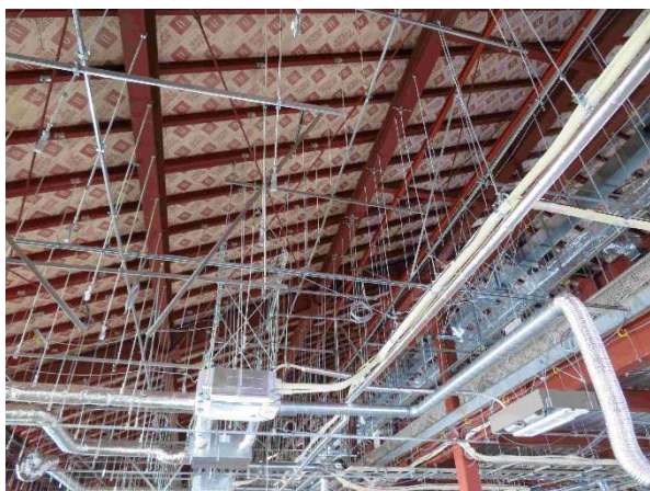
【資料写真 1】 屋内施工状況
