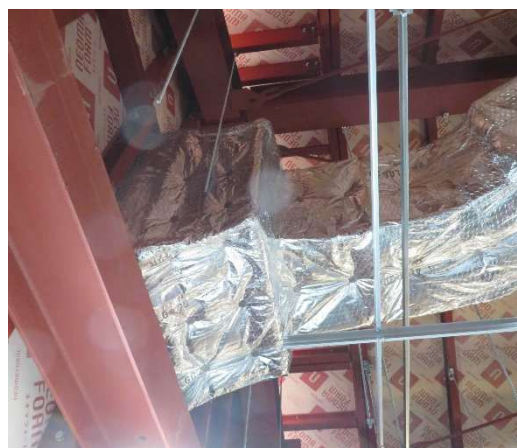
【資料写真 2】 外壁ガラリ内側施工状況
