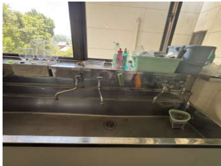
水栓更新②
