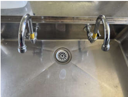
水栓更新①
