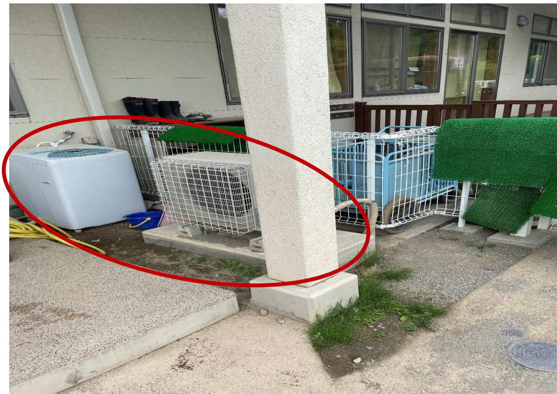
洗濯機・室外機取外し、再取付箇所
