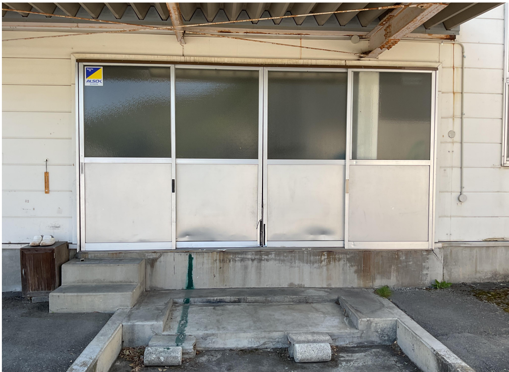
令和8年度 高遠学校給食センター サッシ改修工事 既設搬出口サッシ
