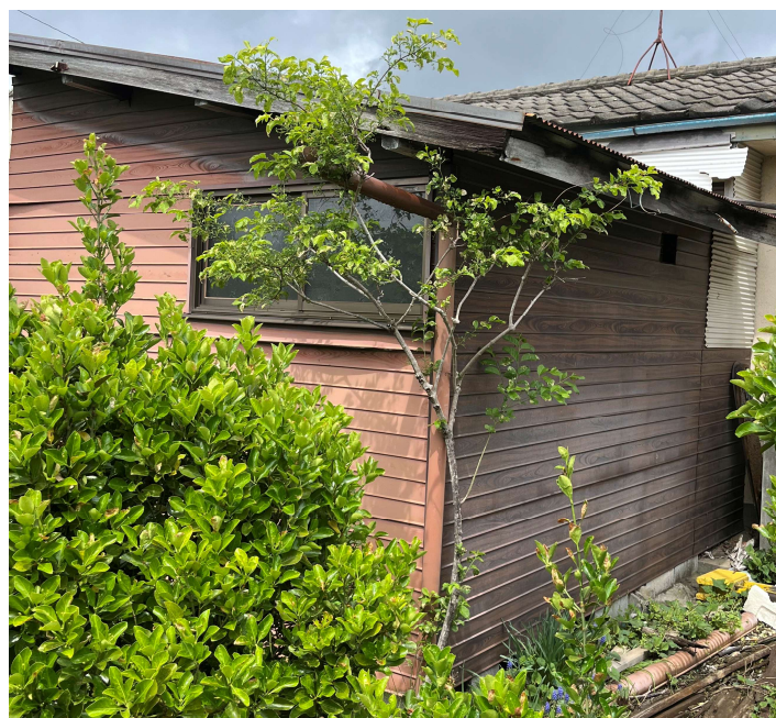
8号室小屋（東側外部）
