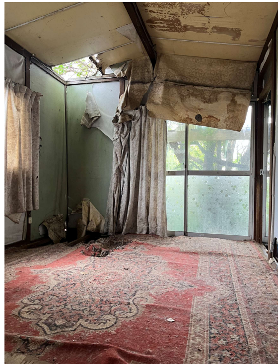
16号室小屋 内部
