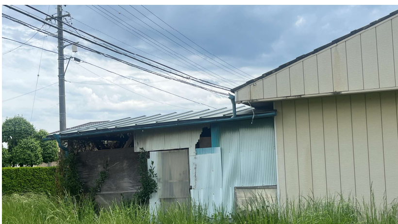
1号室小屋（東側外部）
