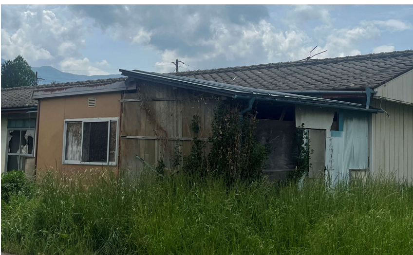
1号室小屋（南側外部）
