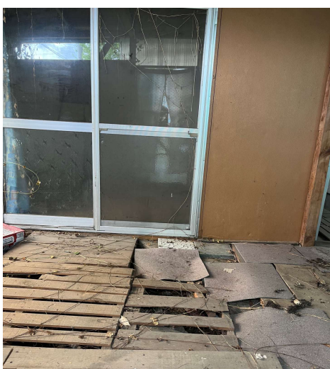
1号室小屋（内部）
