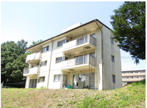
S61 A棟 南東面
