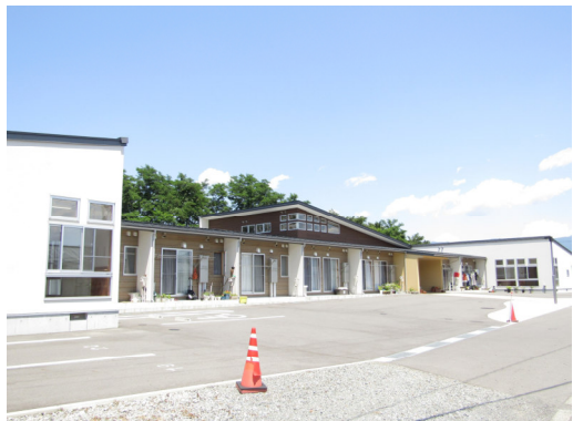
R2 1-1～2-6号棟 南西面
