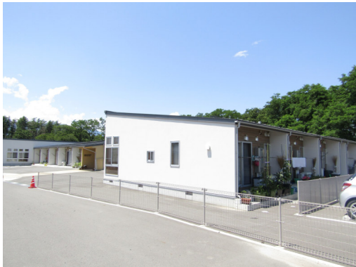
R2 1-1～2-6号棟 南東面
