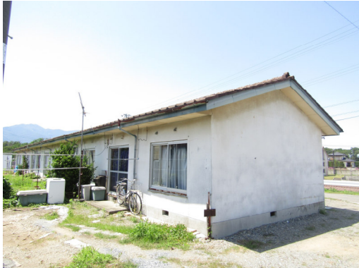
S44 63～68号棟 南東面
