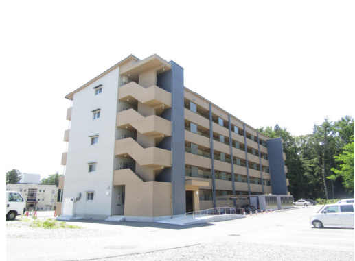
R3 A101～A606号棟 北東面
