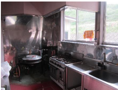
昔はここでも給食を作っていました。今もそのまま回転釜が残っています。給食室
