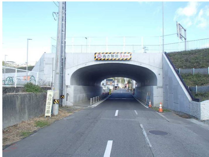
環状南線カルバート
